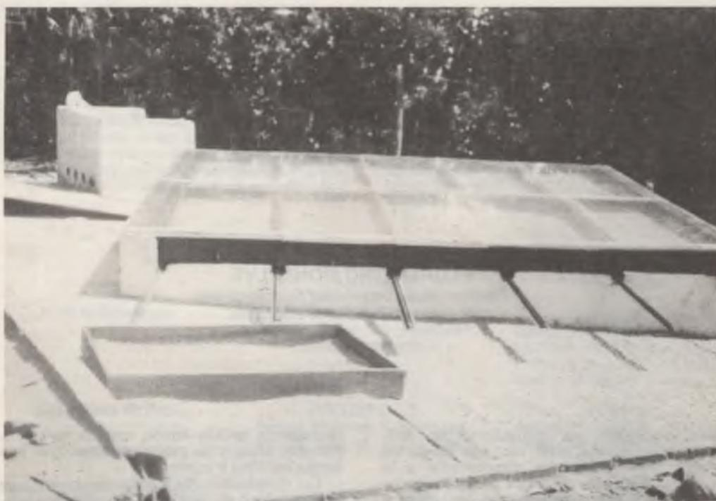
grano se acelera la evaporación del agua que contiene. El vapor de agua se desplaza hacia la cámara baja del horno, cámara fría, y satura el aire de dicha cámara por lo cual este aire húmedo sale al ambiente por las ventanillas laterales. Para evitar que el aire húmedo del ambiente penetra el horno, por la noche o cuando llueve, se tapan las ventanillas laterales en esas circunstancias.
